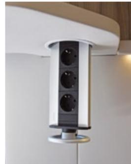
Die Schuko-Steckdosensäule über der Küche arbeitet dank Wechselrichter auch autark.
